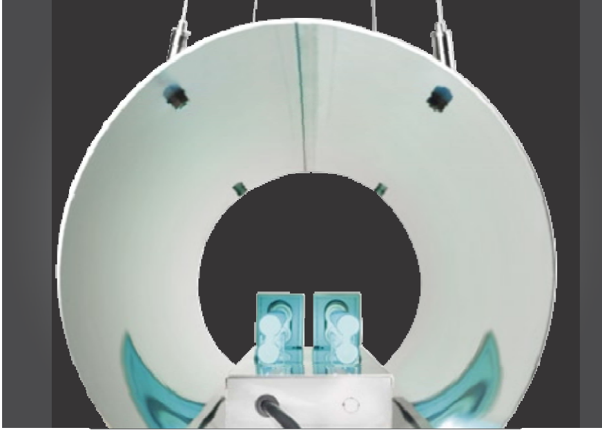
컴팩트형 UV-C 램프가 장착된 AirTube s 내부모습
