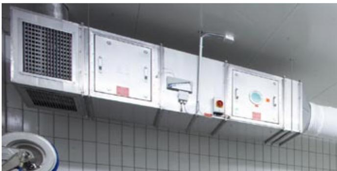
Ausgehend vom deckenmontierten UV-C-Entkeimungssystem gelangt die entkeimte Luft über einen Luftverteilungsschlauch in den Sliceraum.
